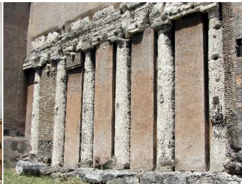
Tempio cattolico romano di S. Nicola in Carcere, a Roma, con le colonne del tempio di GIUNONE SOSPITA incorporate nelle facciate del X secolo e del 1599.
